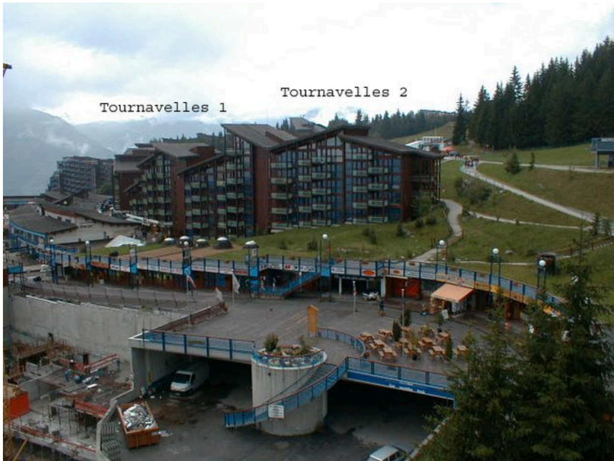
Vue depuis l'ouest
