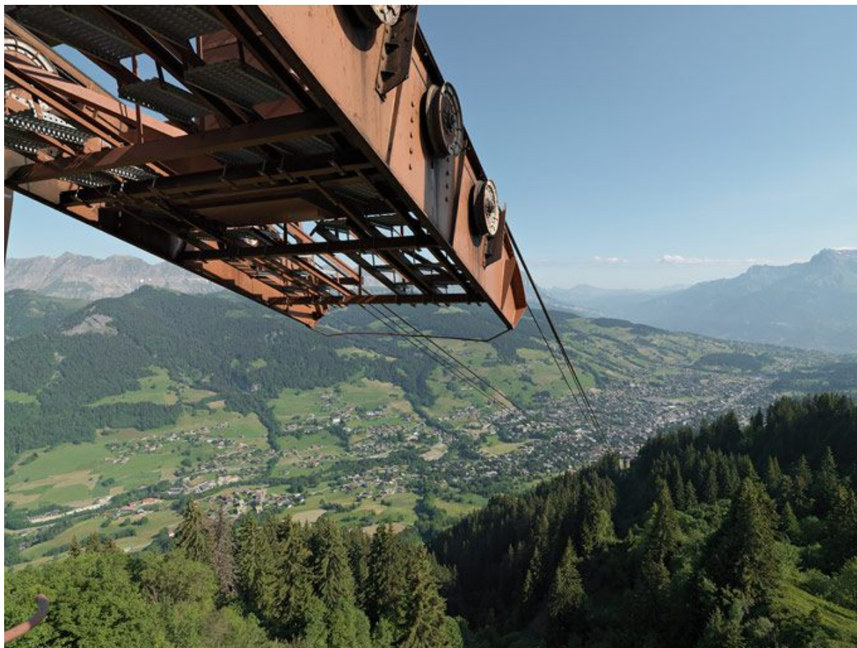
La passerelle de lancement de la gare supérieure
