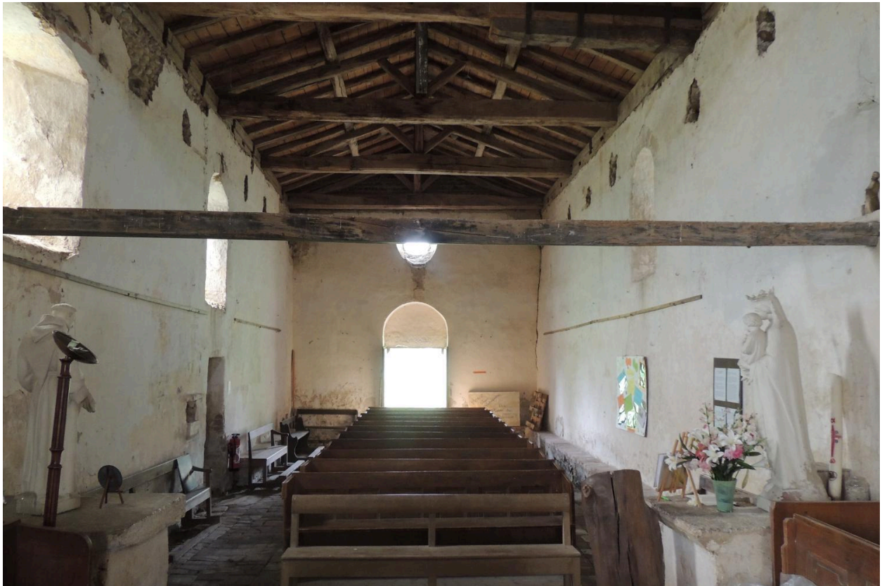
Intérieur, vue en direction de l'entrée.
