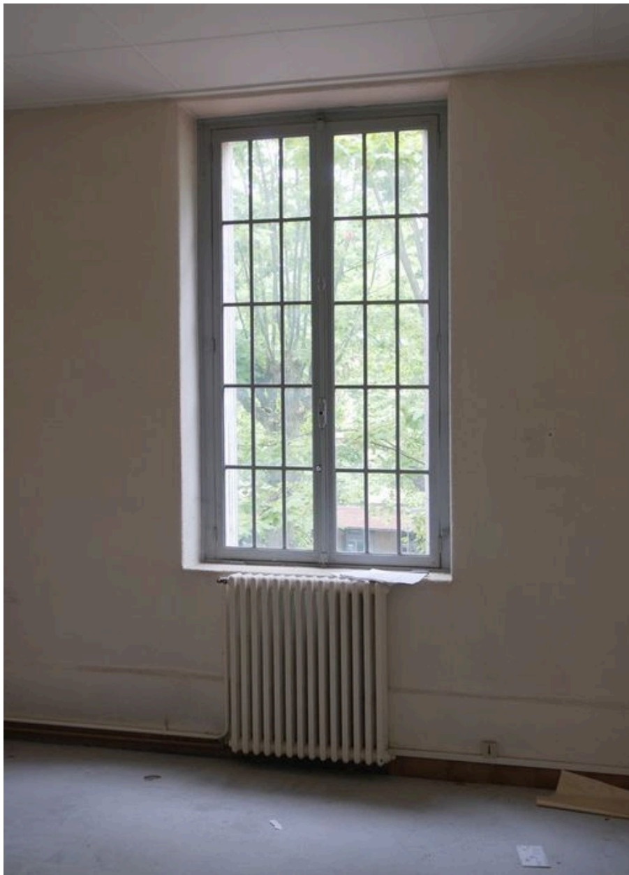
Fenêtre, premier étage
