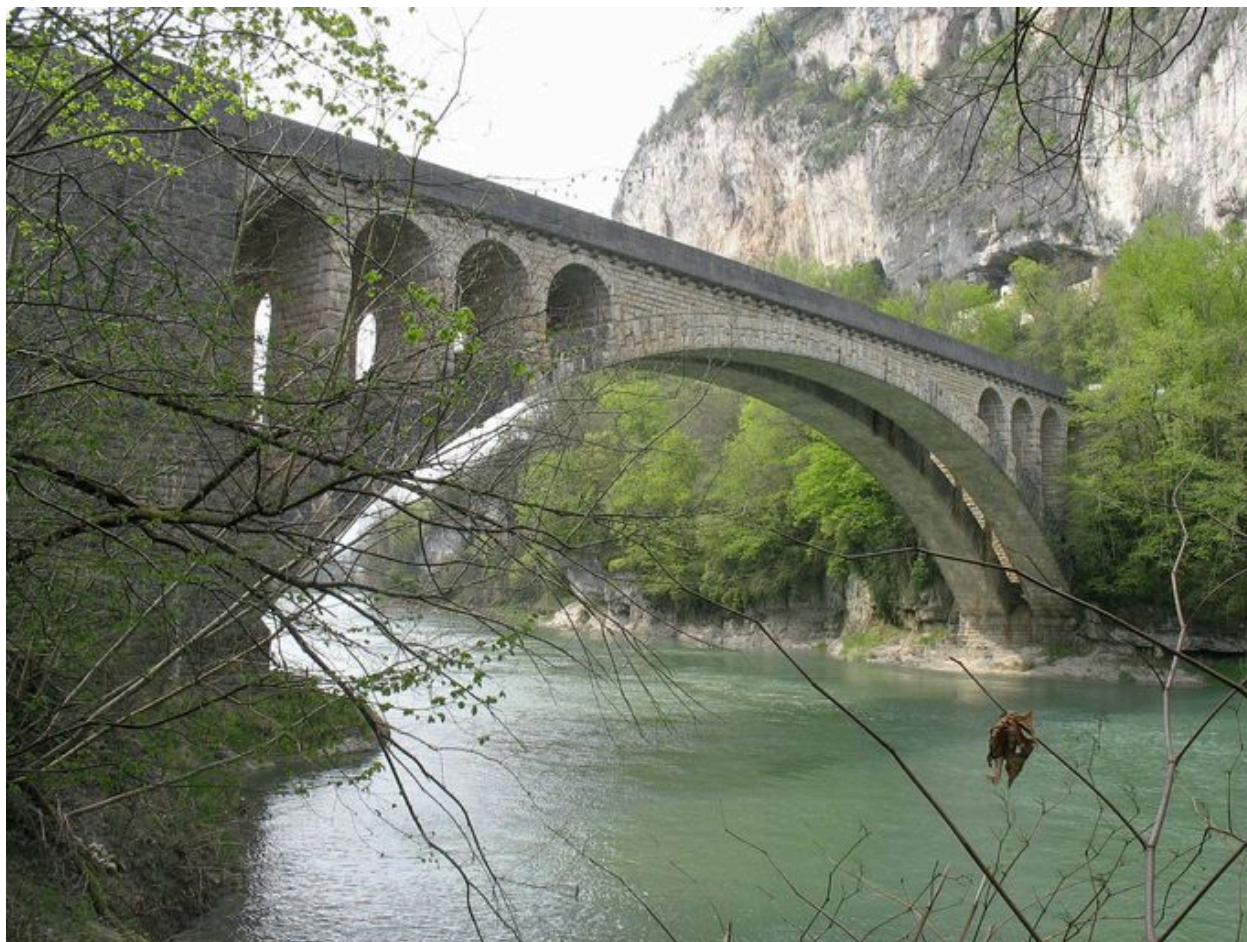
Vue du pont de La Balme (Savoie), face amont ; pont en arc ajouré (1946)
