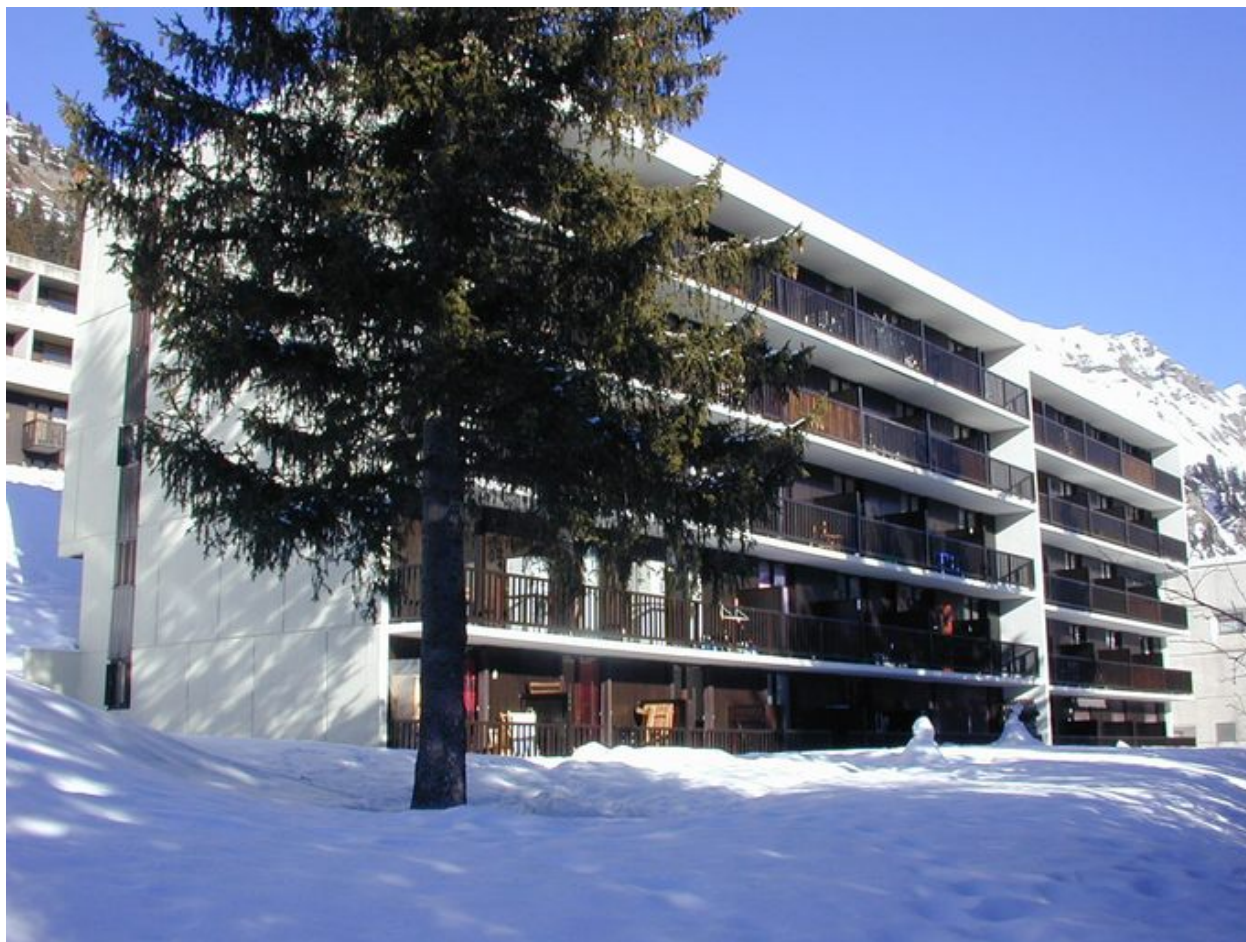
Elévation sud, vue depuis le sud-ouest
