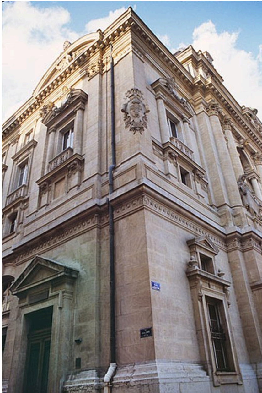
Elévation antérieure : angle sud, 1992
