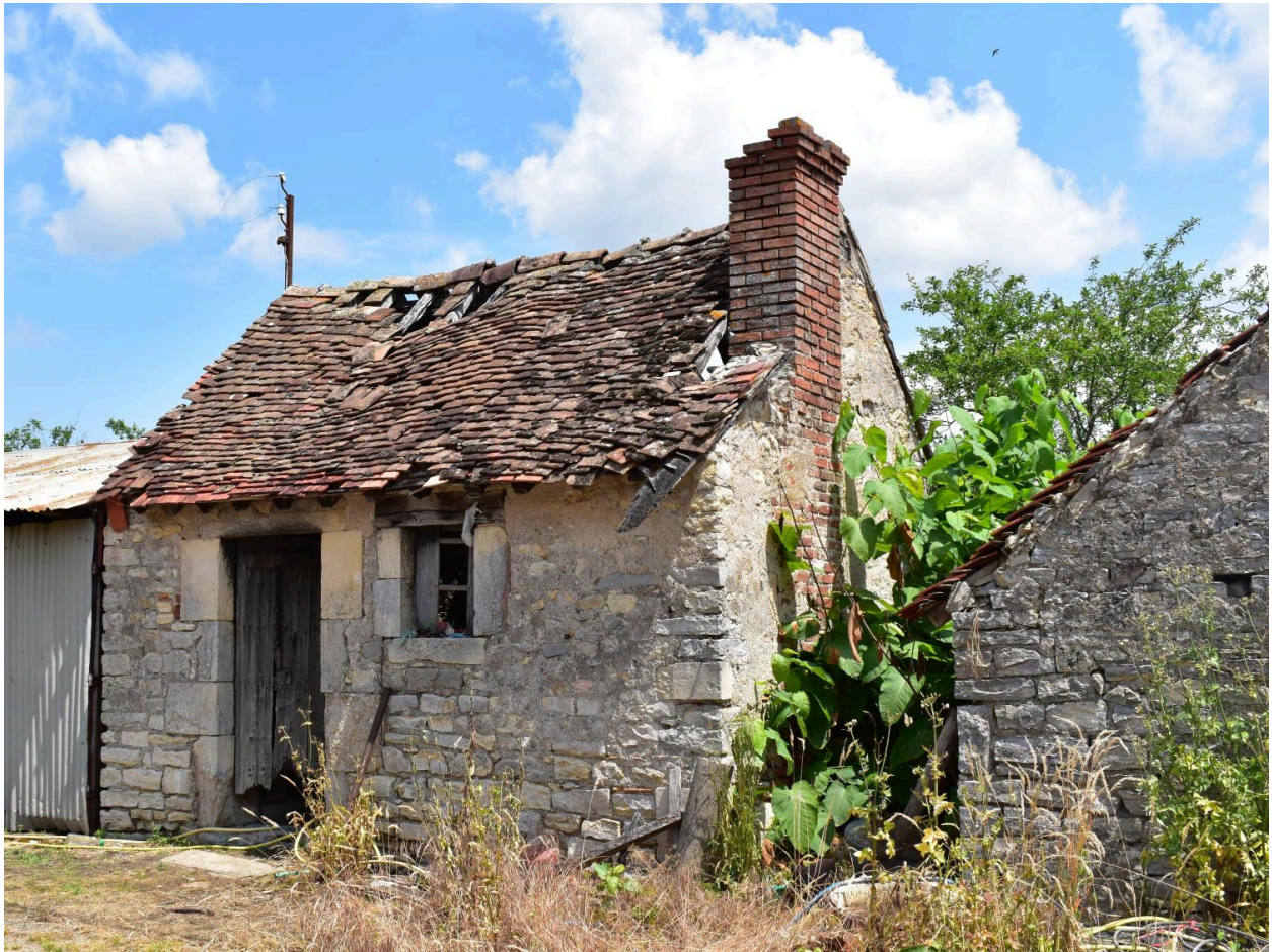
Vue générale de la pièce à cheminée.
