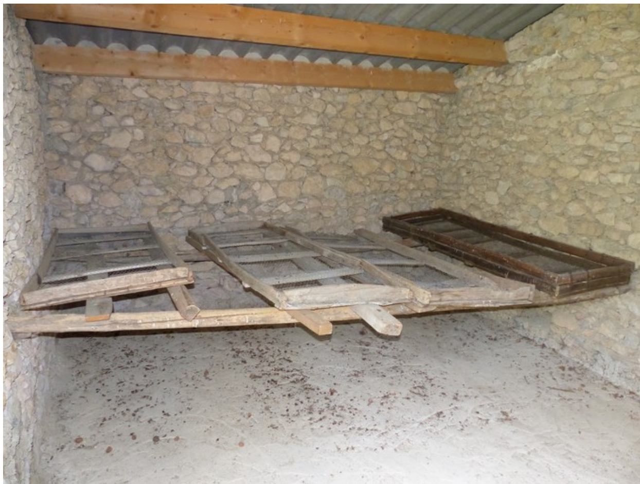
Rez-de-chaussée surélevé, fenil-séchoir. Vue de volume prise du nord-est.
