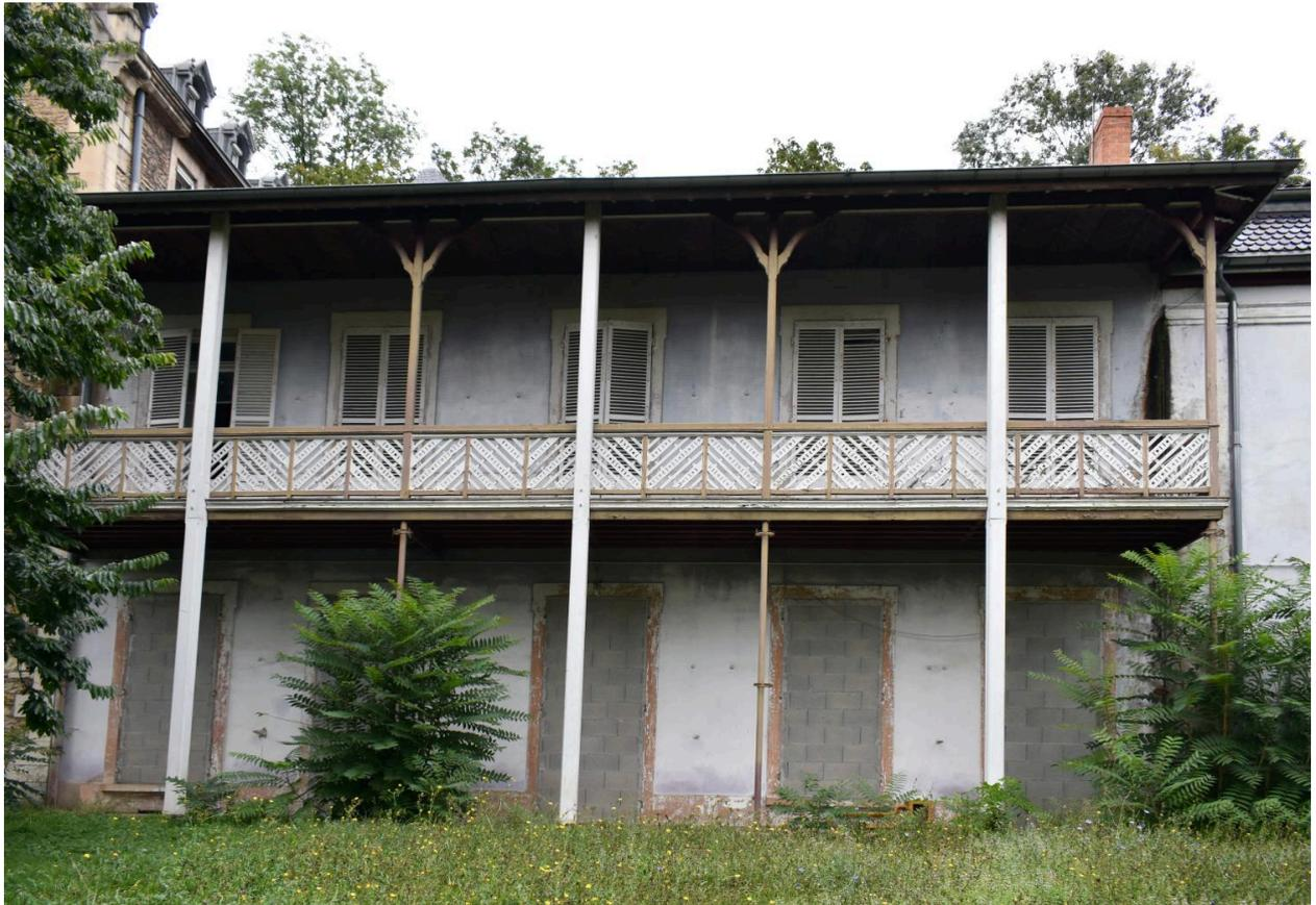
Elévation postérieure : galerie en charpente métallique avec habillage de bois 1/2. des colonnes au rez-de-jardin
