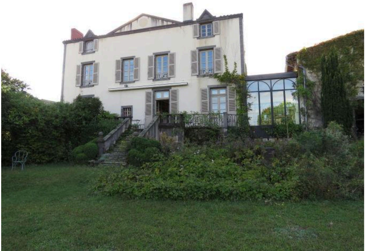
Vue générale : façade sur parc de l'aile est
