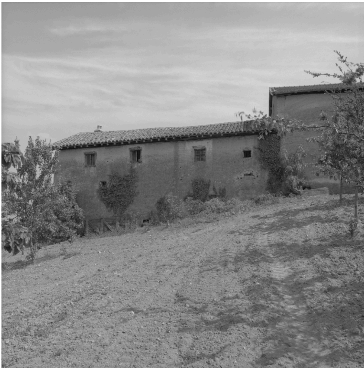
Premier logis, vue d'ensemble de la façade postérieure.
