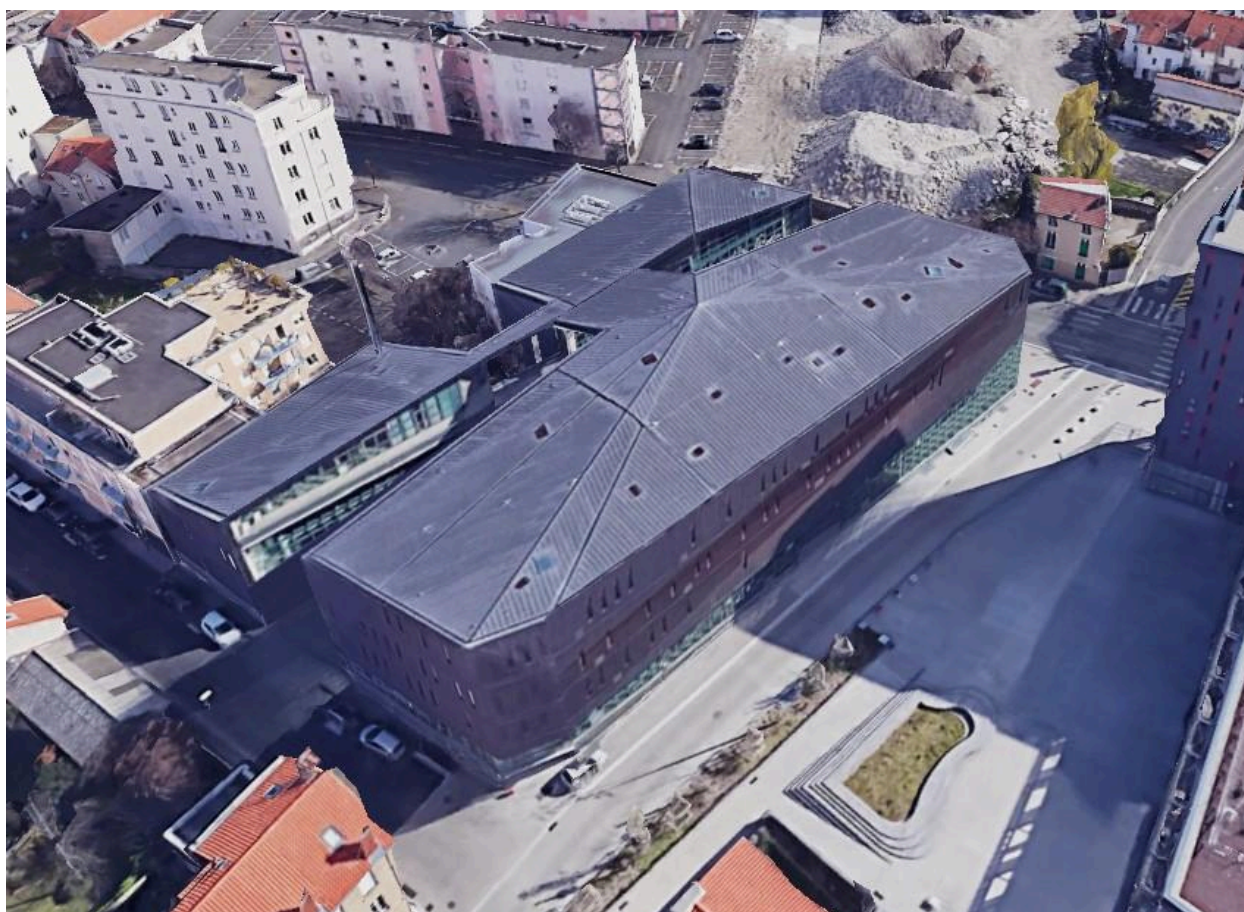
Vue aérienne de la toiture depuis l'angle des rue Kessler et Charles-Fabre
