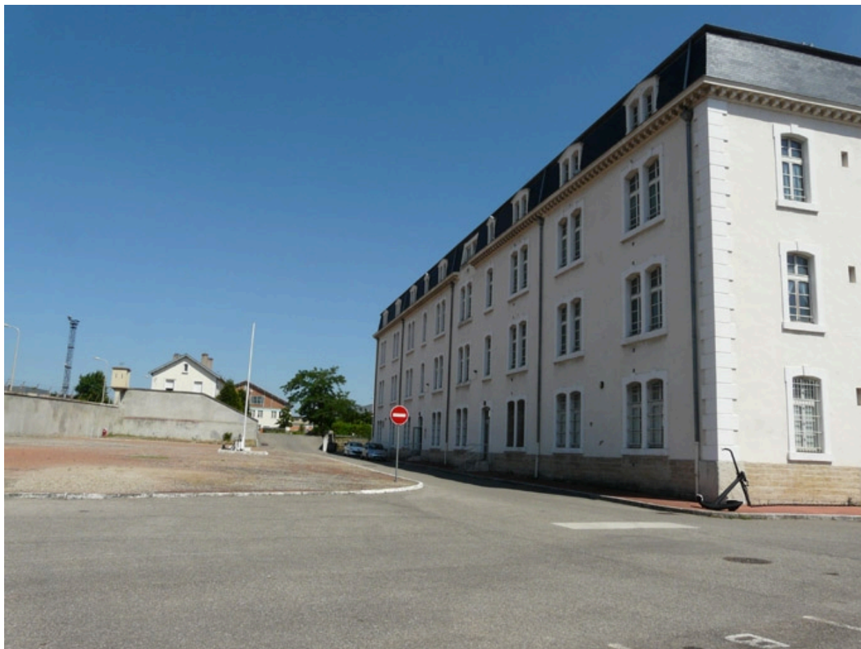
Vue nord du bâtiment n° 6
