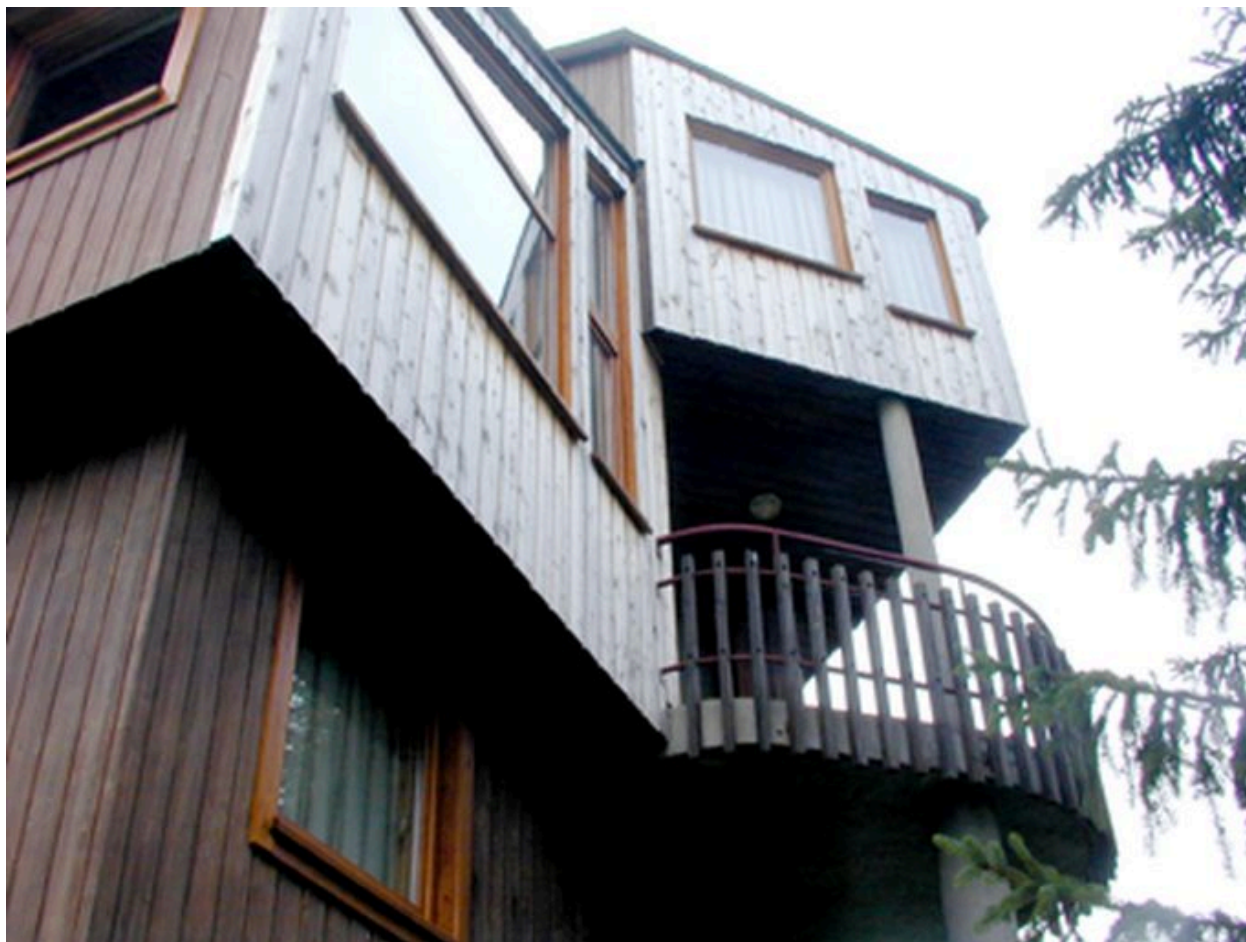
Détail du balcon
