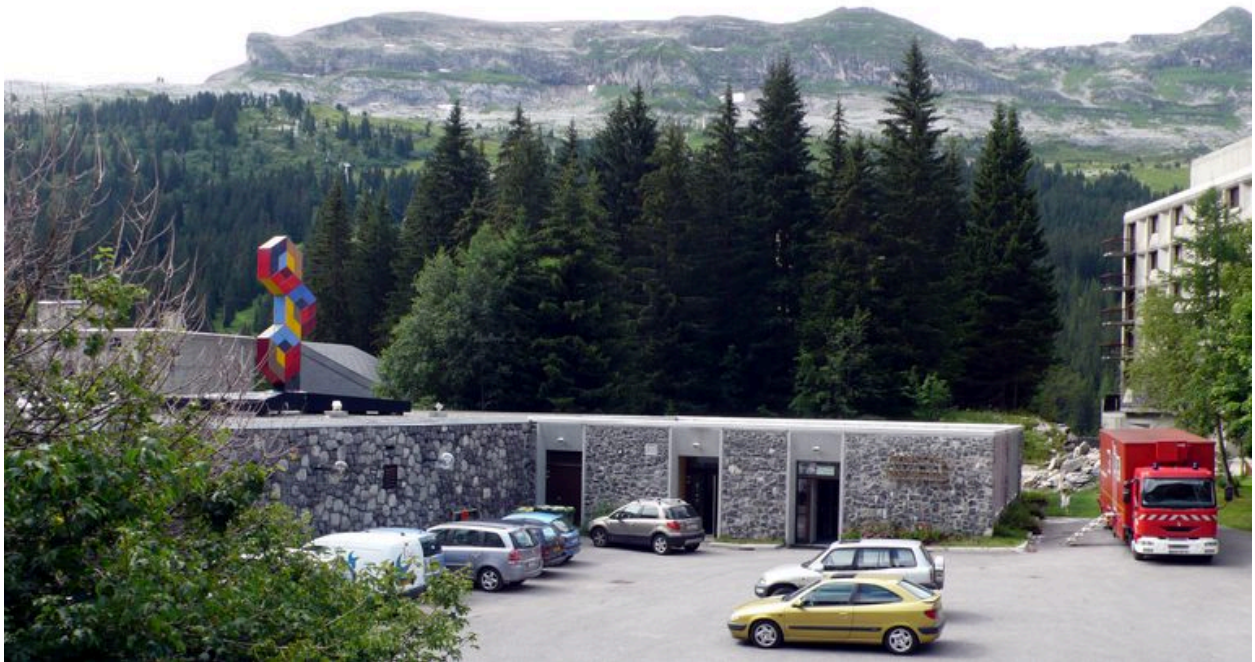
Vue depuis le nord : la maison médicale
