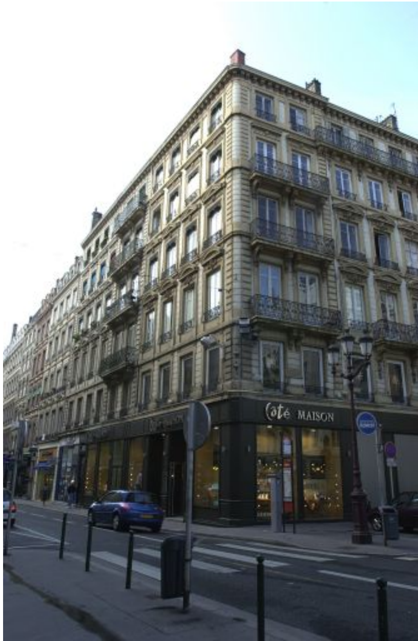
Vue générale à l'angle de la rue de Brest et de la place Saint-Nizer
