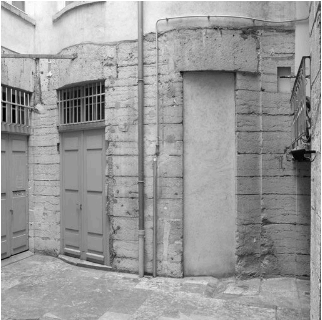
Première cour, rez-de-chaussée du corps de liaison, nord
