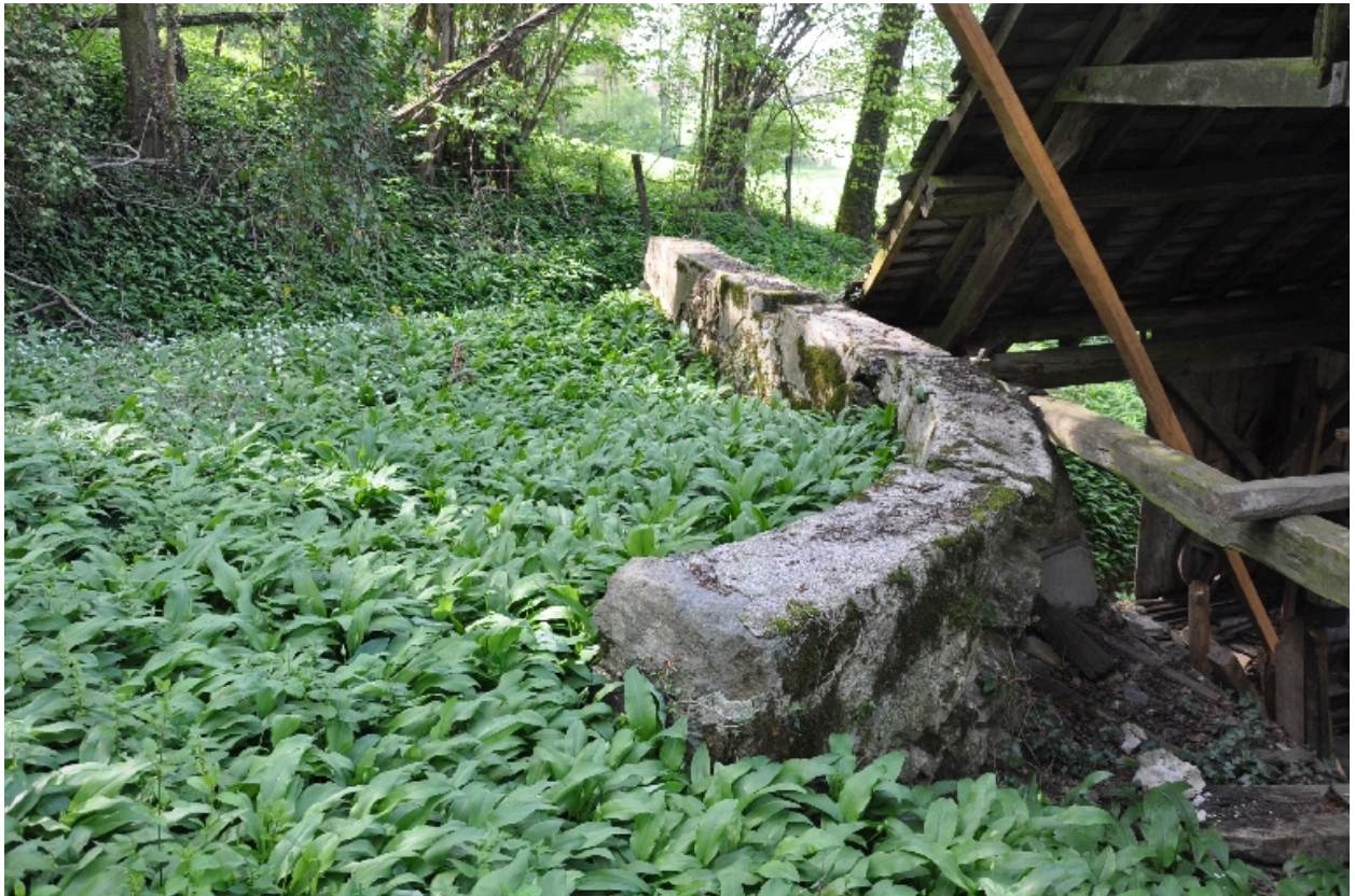
Vue du mur de soutènement de la retenue d'eau
