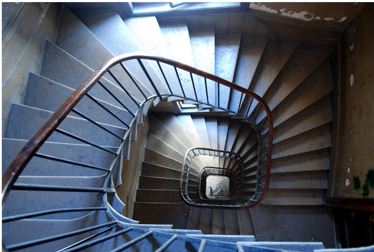
Corps de bâtiment sud : vue en plongée de l'escalier
