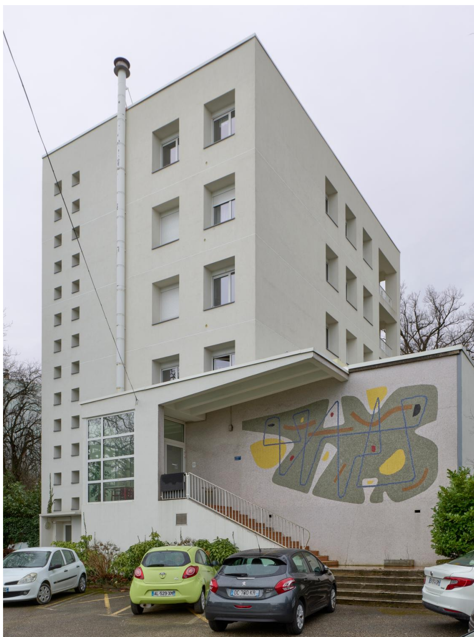
Vue générale, dans son environnement.
