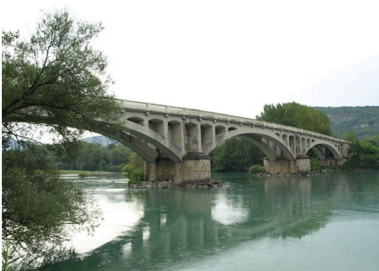
Vue rapprochée, face amont (depuis la rive gauche)
