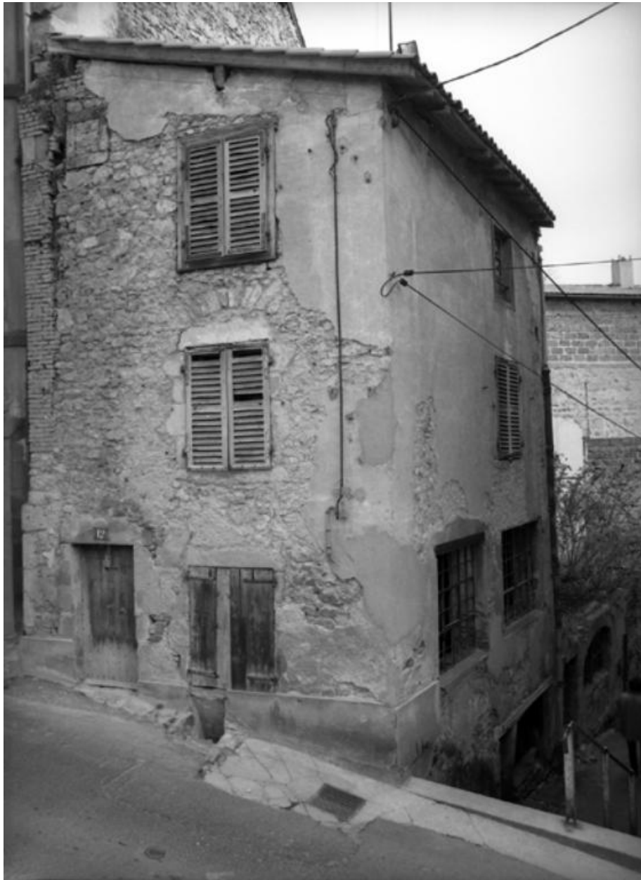
Maison sur atelier de coutellerie, au n° 12 de la rue, avant travaux de réaménagement.
