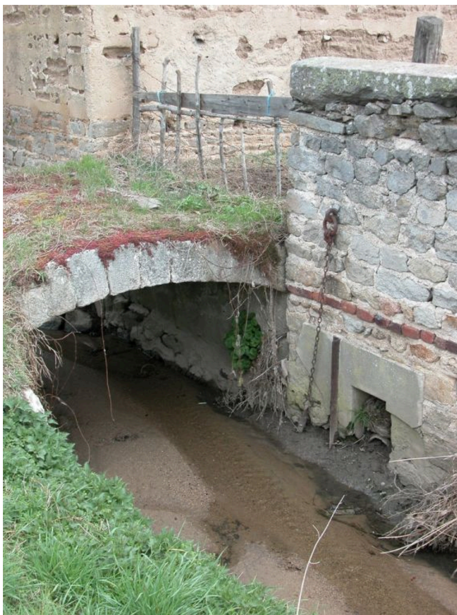
Détail du ponceau sur le ruisseau de la Madeleine.
