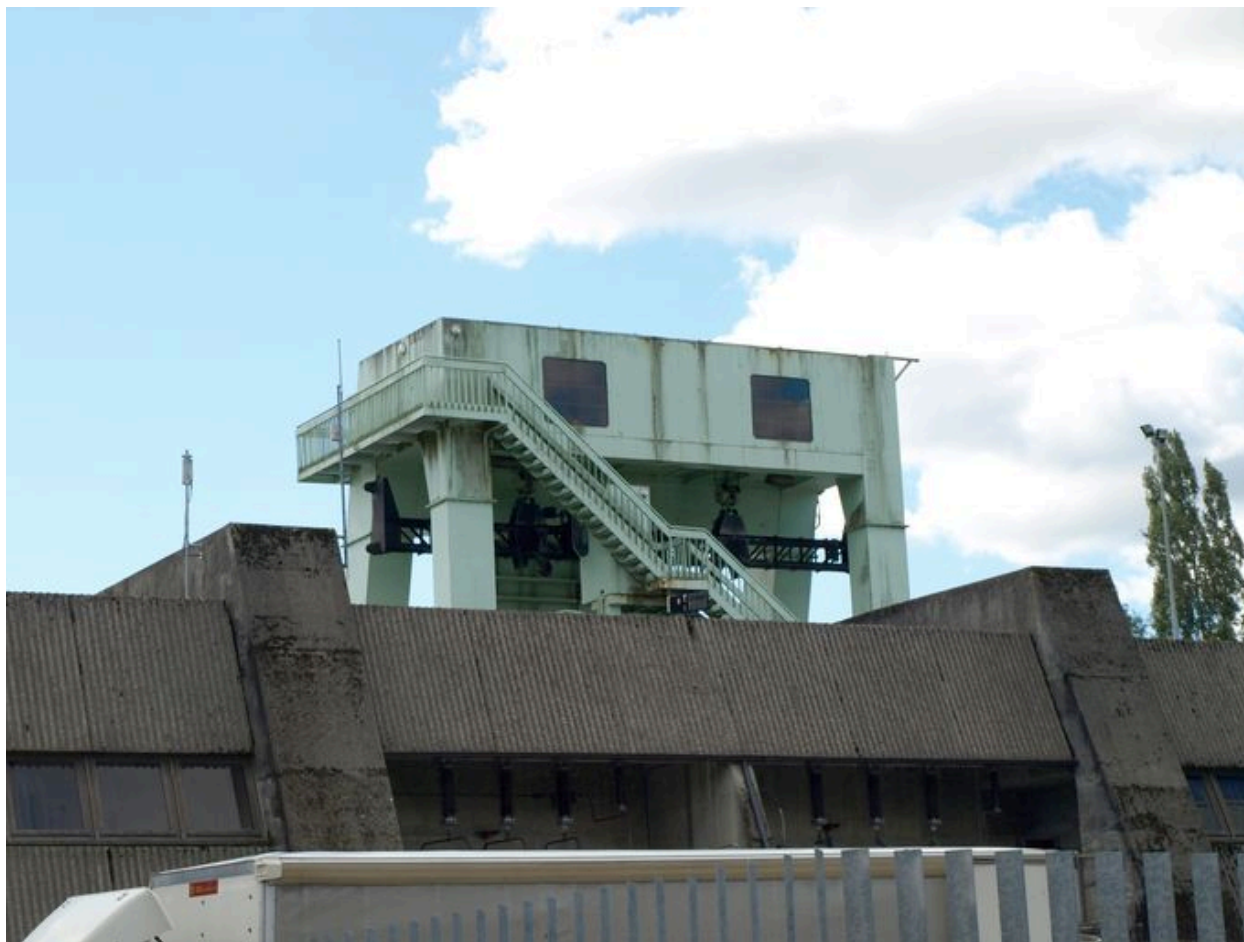
Machine, vue partielle aval (depuis la rive gauche)
