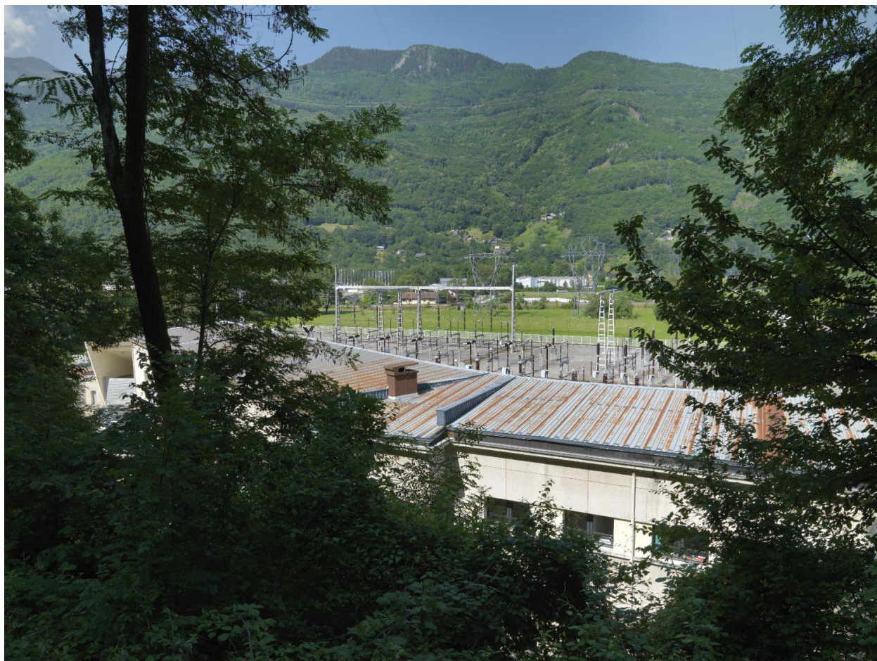
Vue d'ensemble est
