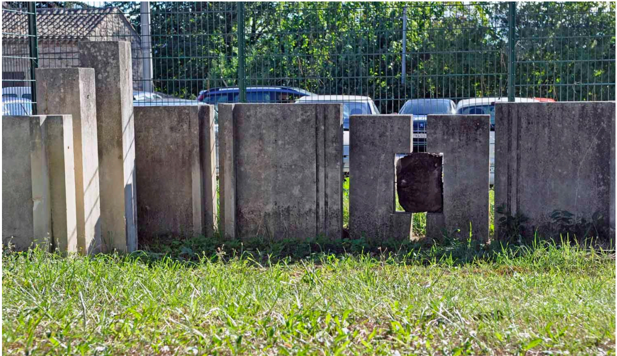
Partie nord : détail côté ouest
