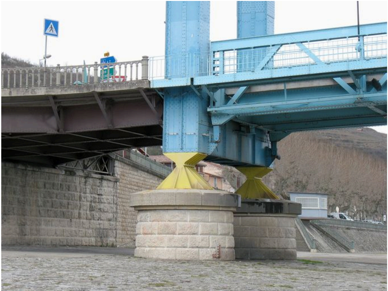
Rive droite : partie inférieure du pylône, socles
