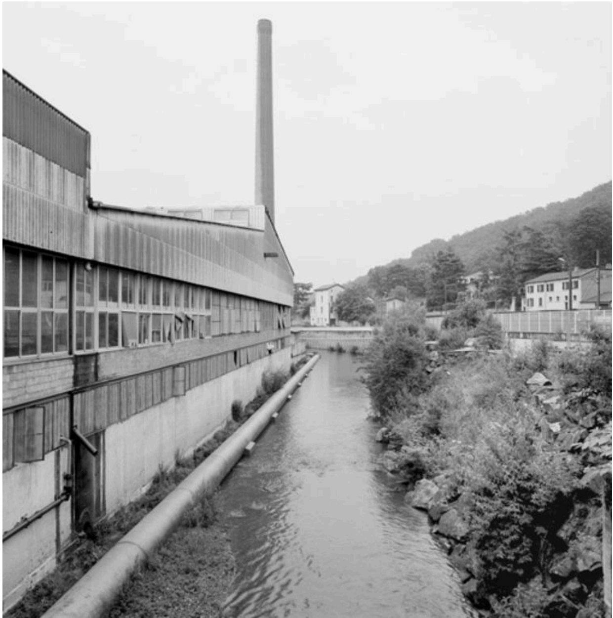
Façade de la verrerie le long du Gier.
