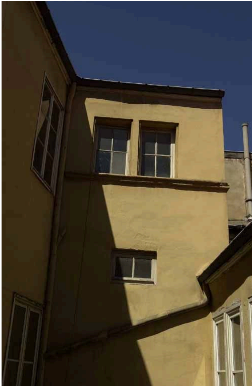
Corps de bâtiment ouest : pavillon terminant la cage d'escalier
