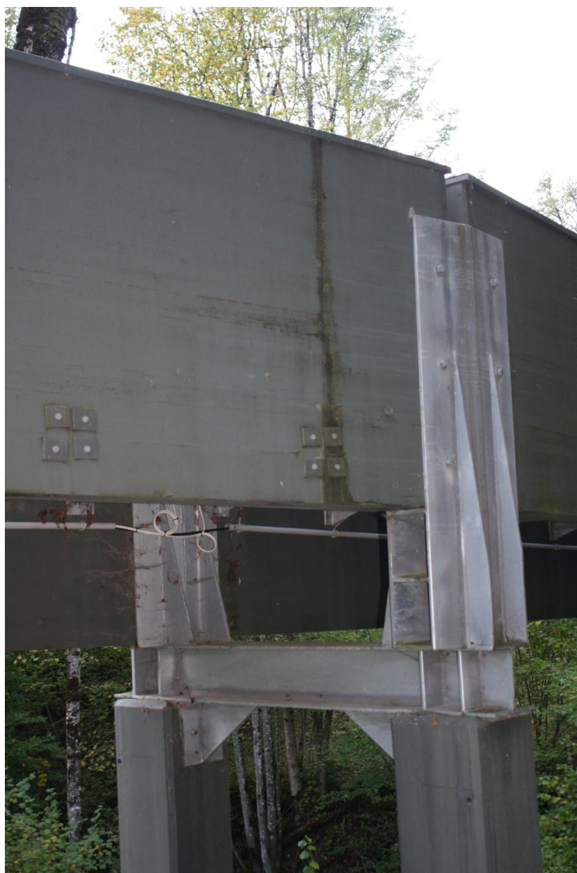
Passerelle de l'Abbaye d'Aulps, détail liaison pile-tablier
