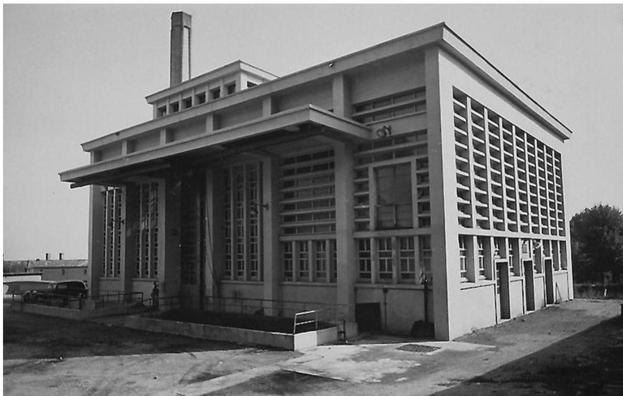
Antiquaille. La nouvelle chaufferie, fotogr. par Blanc et Demilly, 1960
