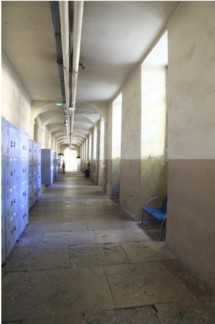
Bâtiment C. Rez-de-chaussée. Galerie orientale. Vue sud-nord.
