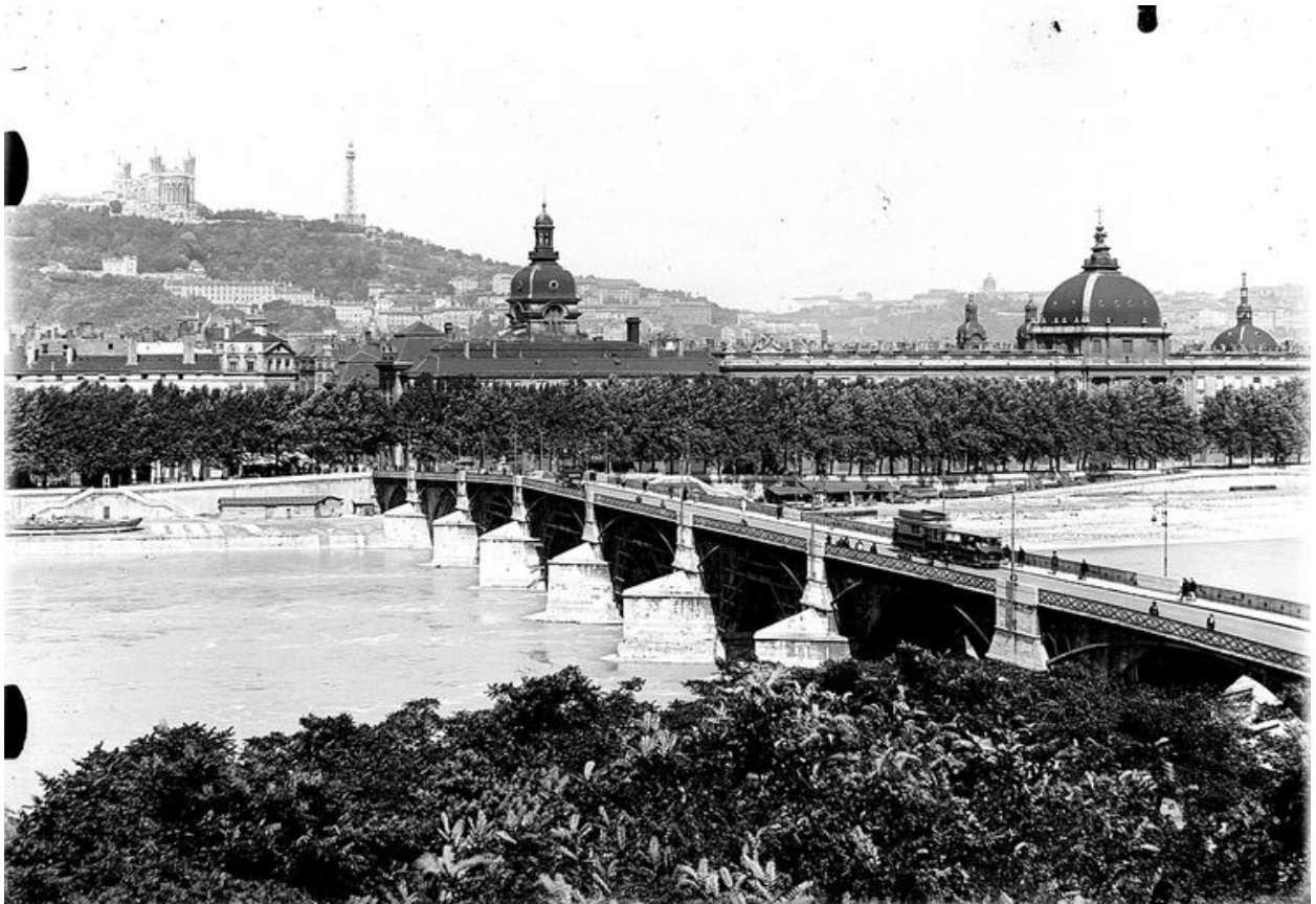
Le pont de la Guillotière depuis le sud-est. Photogr., vers 1940 (AC Lyon 3 PH407)
