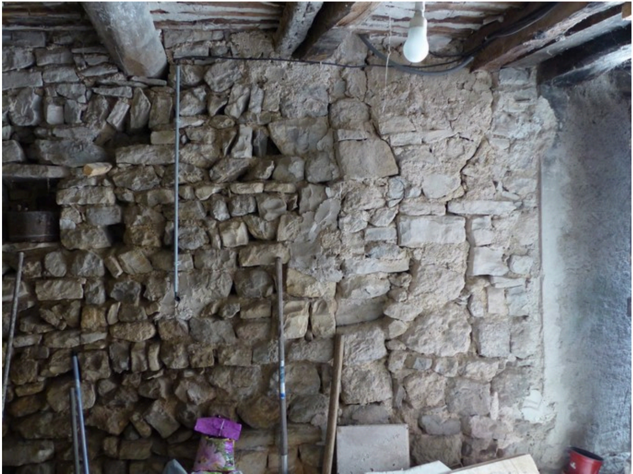
Rez-de-chaussée, étable ouest. Mur ouest, partie nord.
