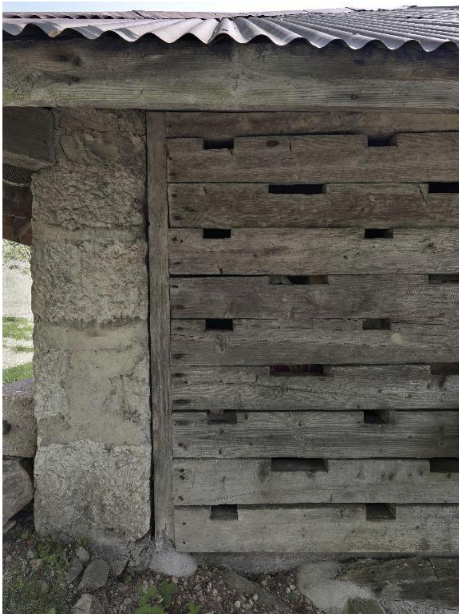
Vue du mur en madrier du freidi.
