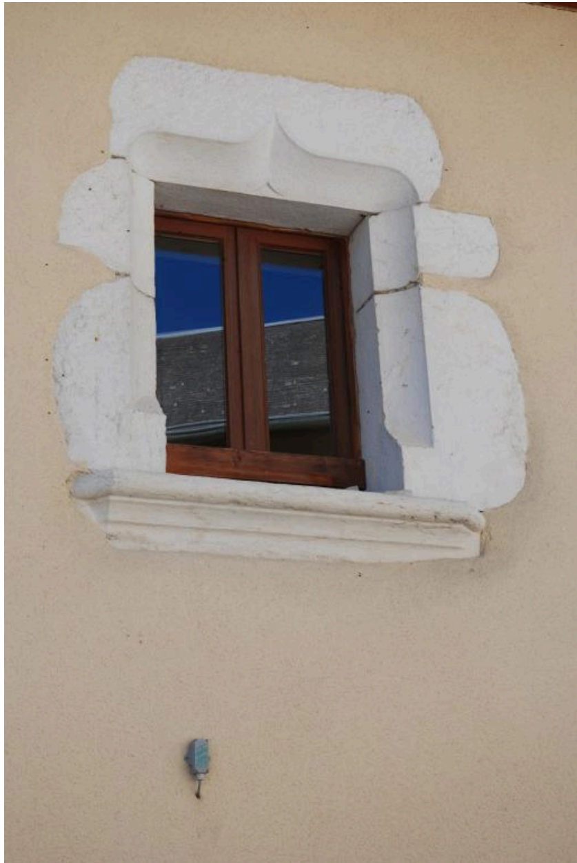
Détail : fenêtre (1er étage, côté rue).
