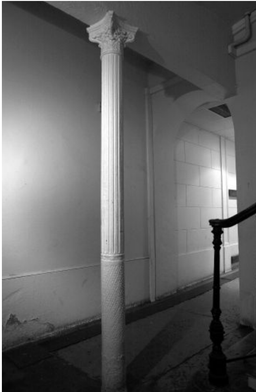
Escalier, colonne en fonte du palier du rez-de-chaussée
