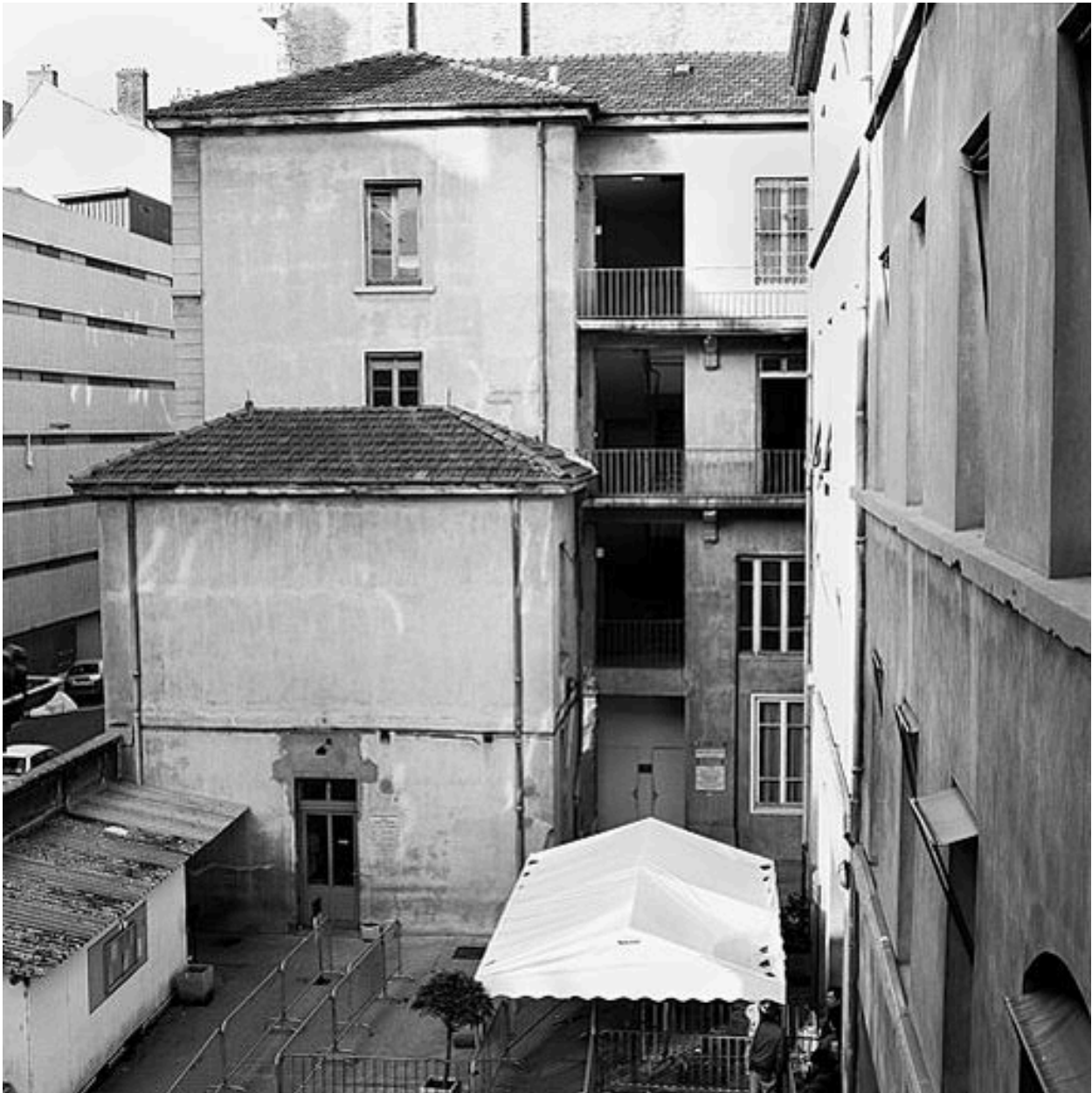
Corps de bâtiment nord et sa cage d'escalier
