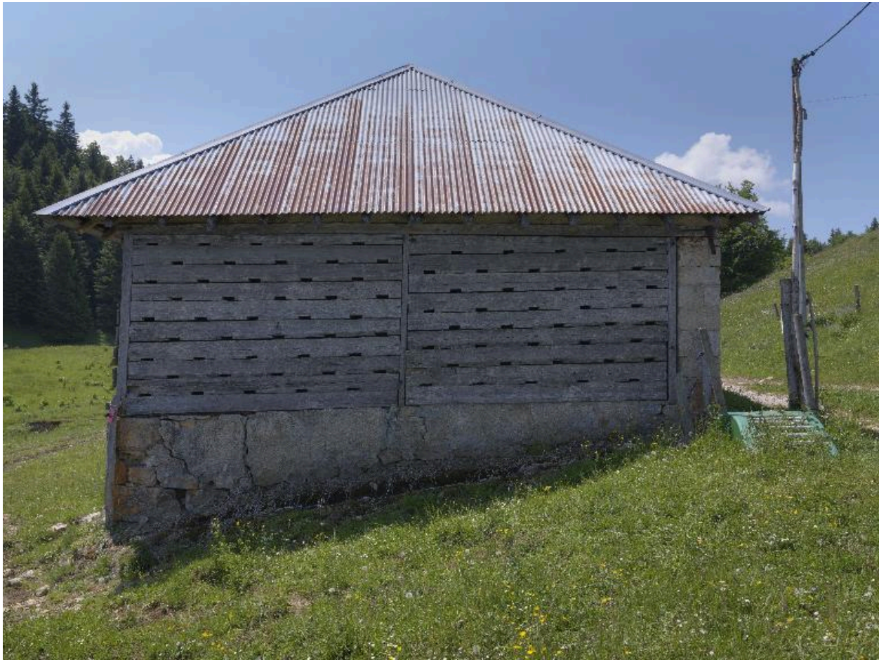
Vue du bâtiment nord, face nord : madriers ajourés pour l'aération du freidi.
