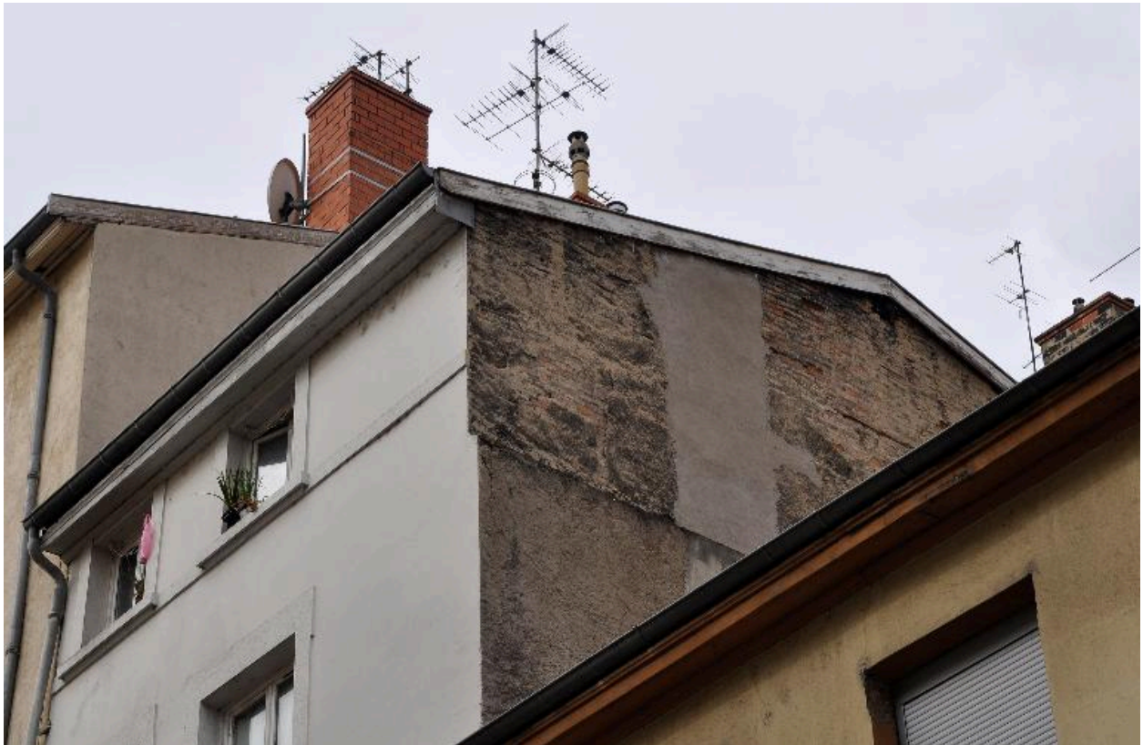
Vue rapprochée du mur pignon, montrant la surélévation en briques
