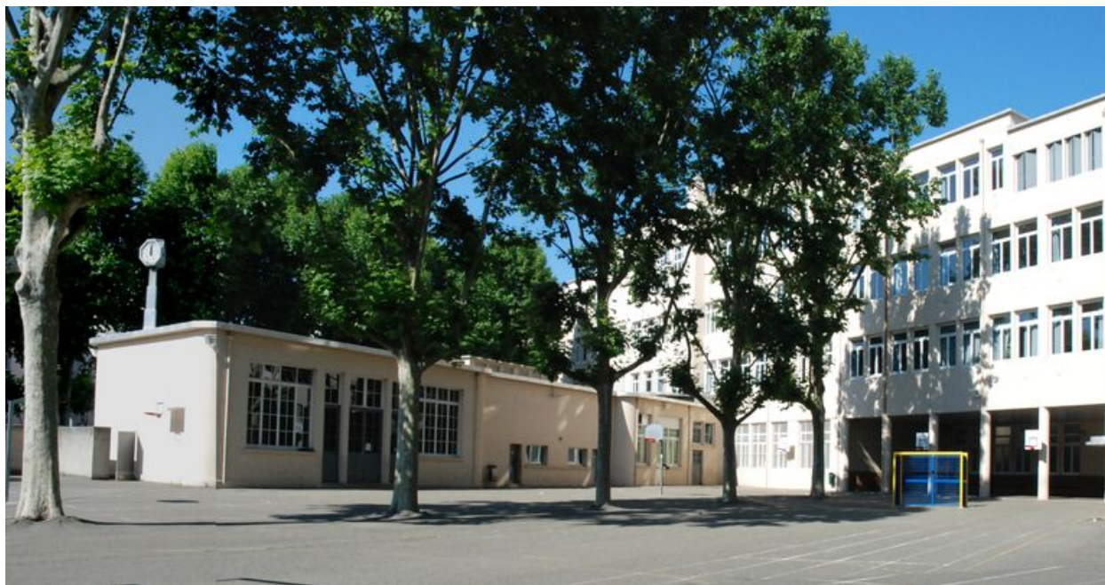
Elévations sur cour, avec le bâtiment annexe
