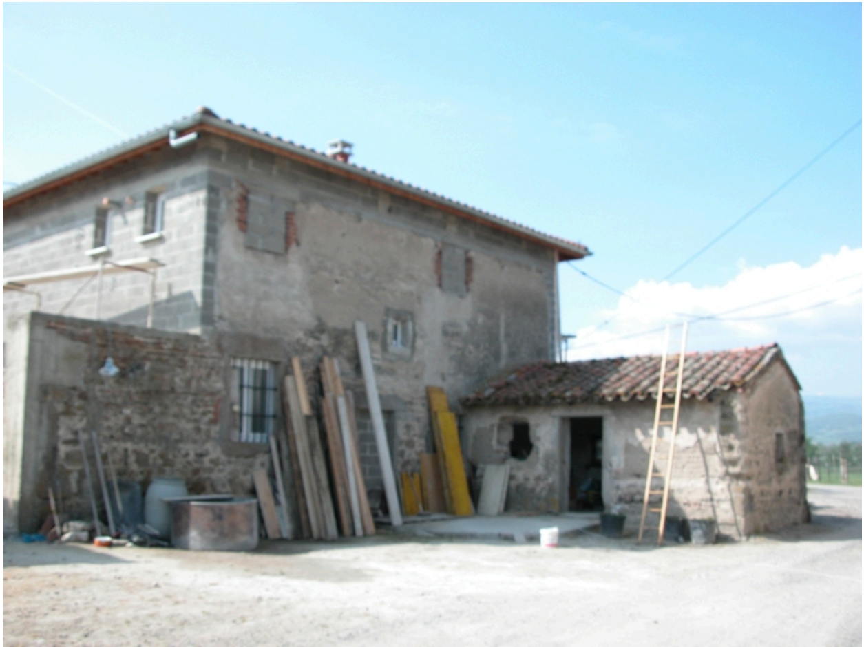
Vue de l'angle sud-ouest de la cour : laiterie, extrémité du bâtiment sud (reconstruite).
