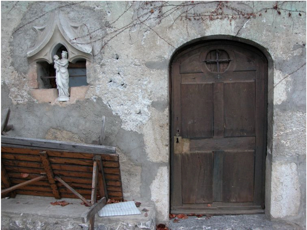
Baie trilobée et porte de cave en plein cintre.
