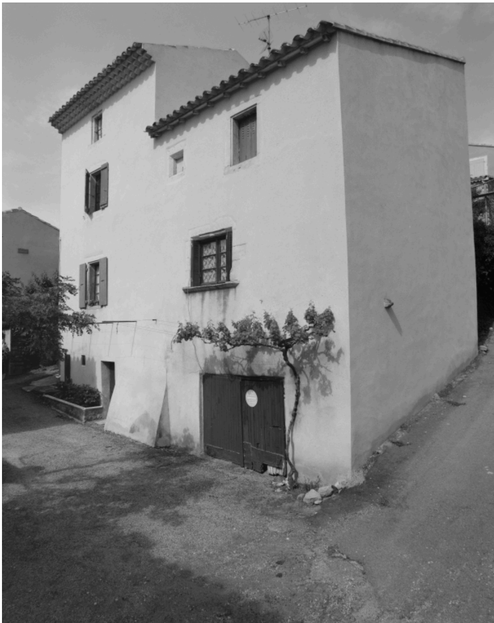
Élévation principale de la maison (B1 823).
