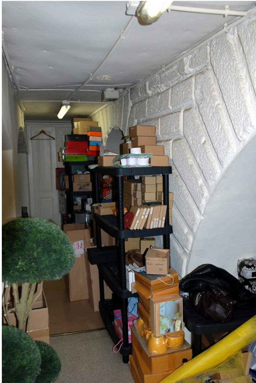
Intérieur ouest entresol, arcade du XVIIe
