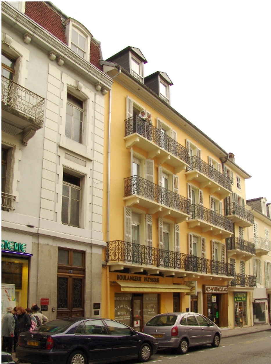
Façade sur la rue de Chambéry
