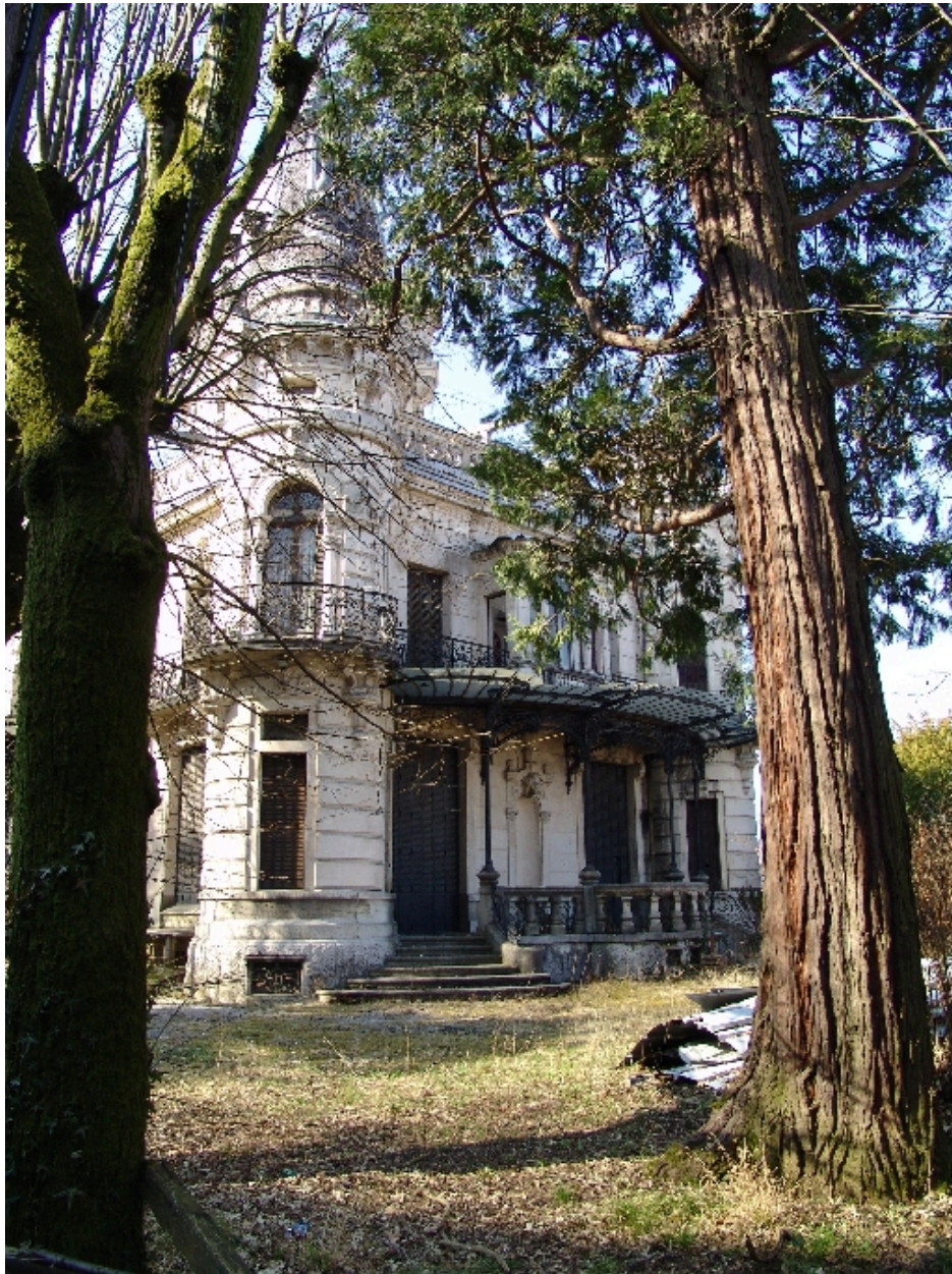
Façade latérale nord, vue de trois-quart gauche
