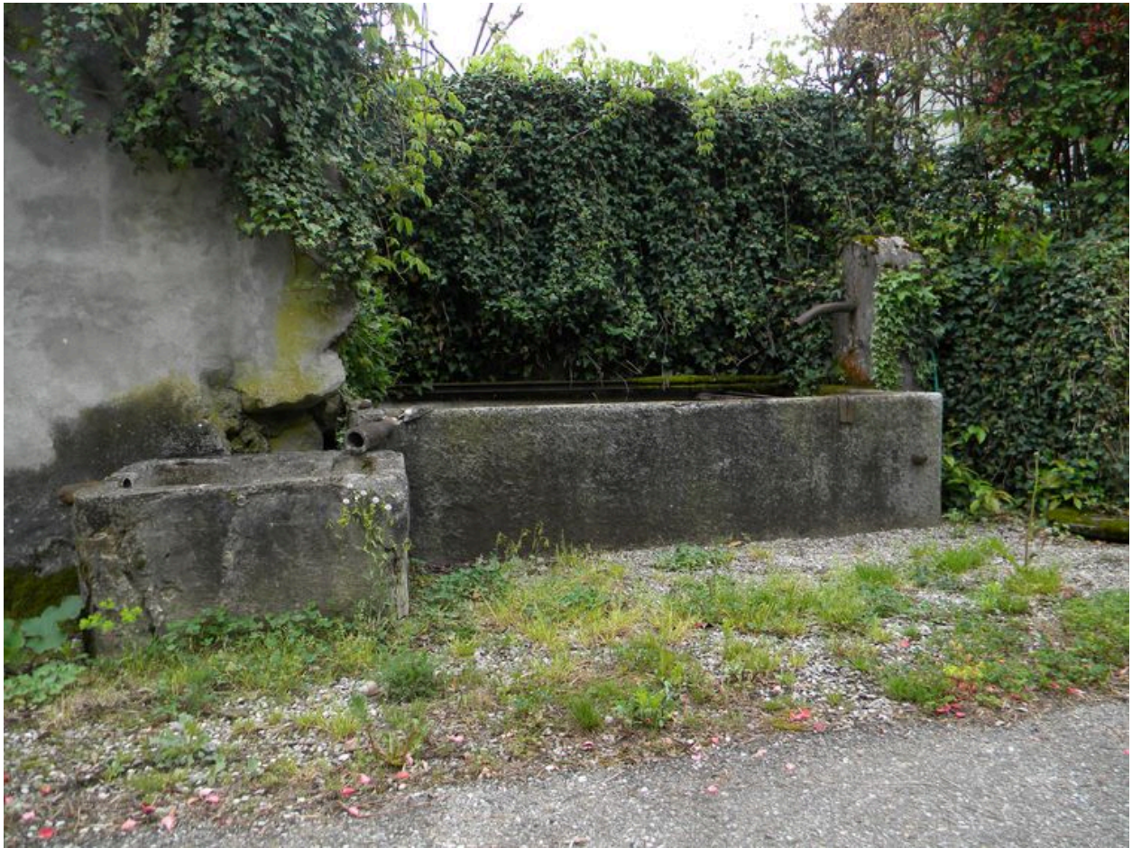
Vue générale du bassin à sec.
