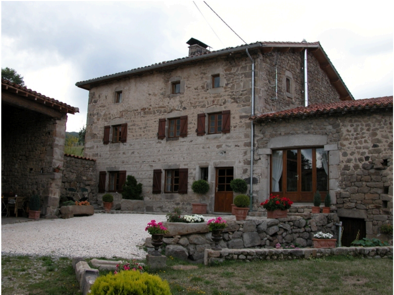
Vue d'ensemble du logis et de la première grange, depuis l'est.
